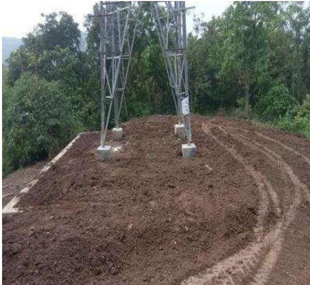
PONDASI BARU TOWER 117
