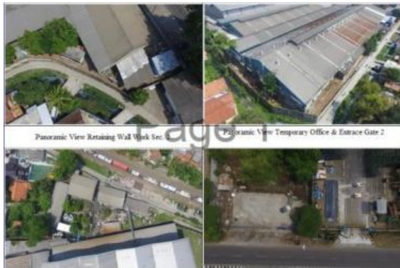
Kondisi awal tampak dari Atas
