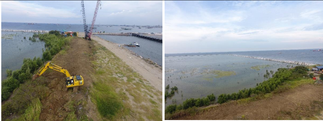
Gambar 3. Kondisi Eksisting Pekerjaan di Terminal Kalibaru, Pelabuhan Tanjung Priok
