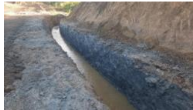
Gambar 10. Sistem drainase untuk mencegah banjir dan erosi
