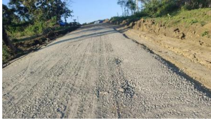
Gambar 2. Jalan akses yang telah selesai dibangun dan siap digunakan.
