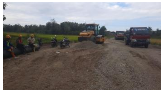
Gambar 4. Jalan akses dengan lapisan batu split .
