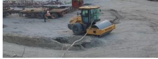
Gambar 6. Pemadatan tanah menggunakan roller compactor .
