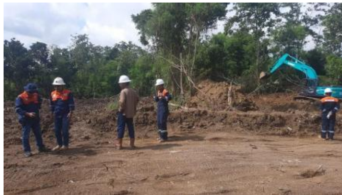
Gambar 1. Proses pembersihan lahan menggunakan excavator .
