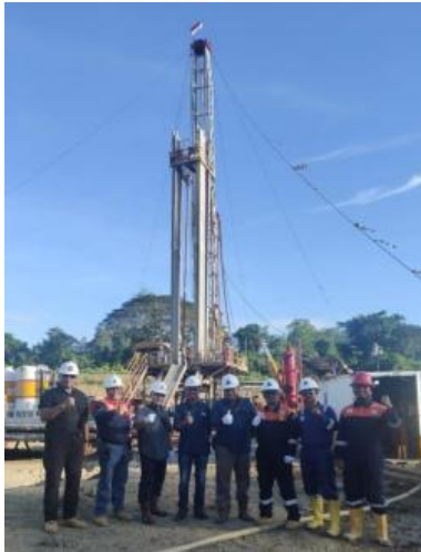
Gambar 9. Rig pengeboran yang telah terpasang di wellpad
