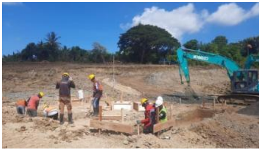
Gambar 7. Pembangunan pondasi rig pengeboran.
