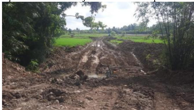
Gambar 3. Akses jalan belum tersedia di lokasi sebelum proyek dimulai.
