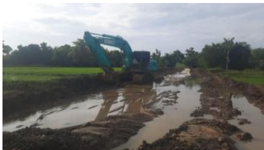
Gambar 3. Pembukaan jalur jalan baru menggunakan alat berat.
