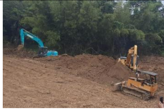
Gambar 10. Alat berat yang digunakan untuk persiapan lokasi pengeboran.
