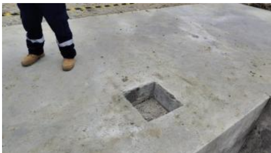
Gambar 4. Pondasi rig pengeboran yang telah selesai dibangun.
