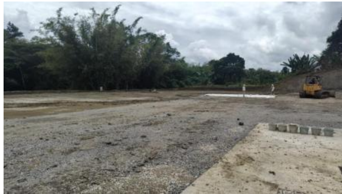
Gambar 3. Area tanah yang telah diratakan dan dipadatkan menggunakan roller compactor.
