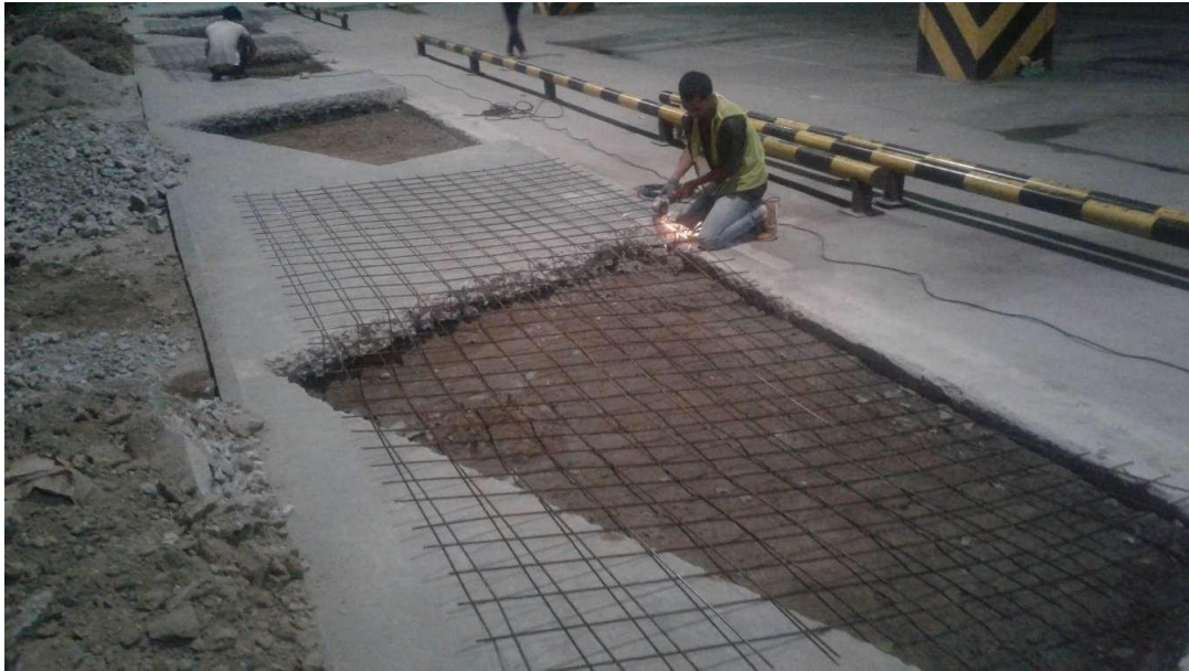
Gambar 5. Pemotongan dan Pemasangan Tulangan Besi Beton
