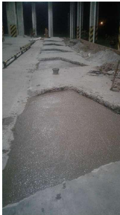
Gambar 8. Hasil Pengecoran Beton
