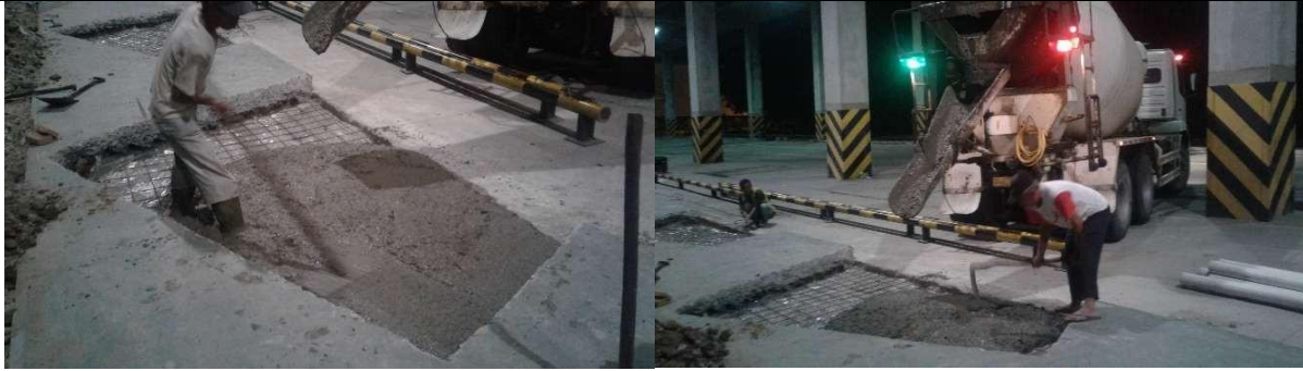
Gambar 7. Pekerjaan Pengecoran Beton
