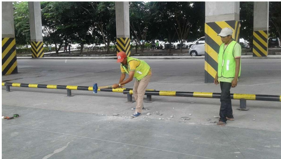
Gambar 4. Pekerjaan Penghancuran Beton Pedestrian
