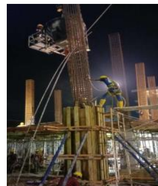
Gambar 12. Pengecoran Kolom
