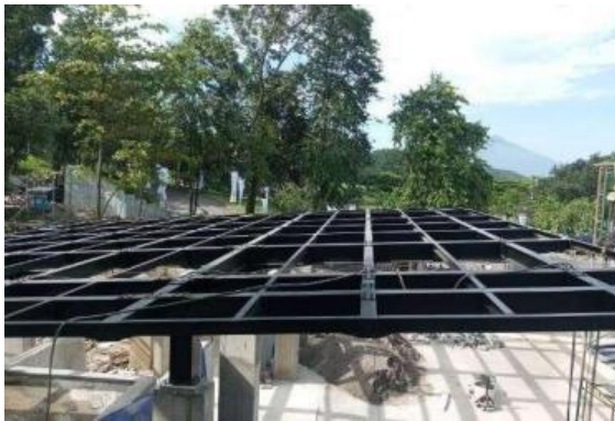
Gambar 35. Pek. Struktur Baja
