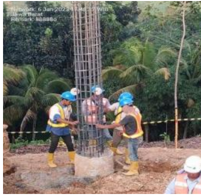
Gambar 5. Pekerjaan Tulangan Bored Pile
