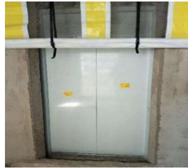
Gambar 23. Pek. Finishing Struktur Lift
