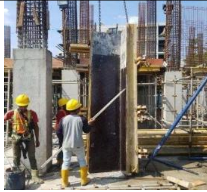
Gambar 14. Pek. Pembongkaran Bekisting
