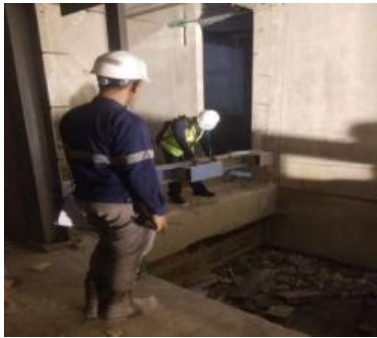
Gambar 22. Pek. Struktur Shaft Lift
