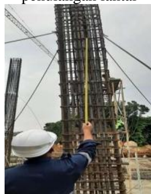
Gambar 10. Quality Check Penulangan Kolom
