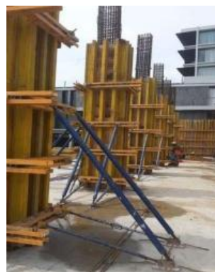
Gambar 11. Pek. Bekisting Kolom
