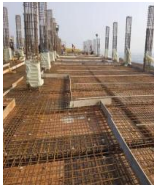
Gambar 7. Pek. Bekisting dan penulangan lantai
