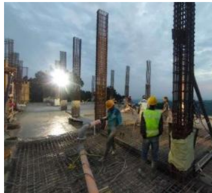
Gambar 8. Pengecoran Lantai
