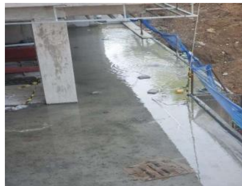
Gambar 17. Test Rendam Dak Beton
