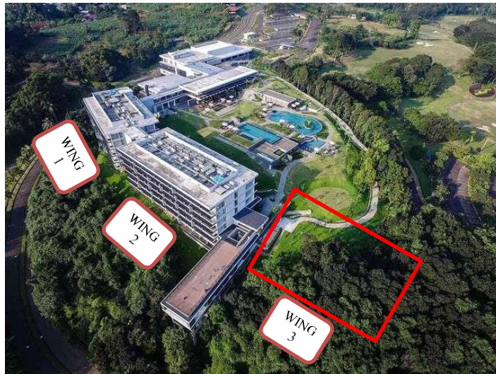
Gambar 3. Kondisi eksisting proyek sebelum pembangunan Extension Wing 3
