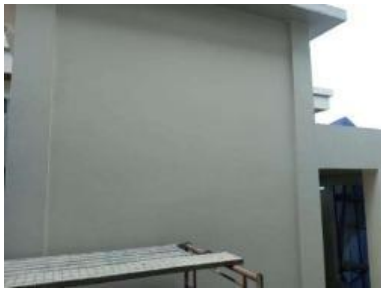
Gambar 31. Pek. Pengecatan Dinding
