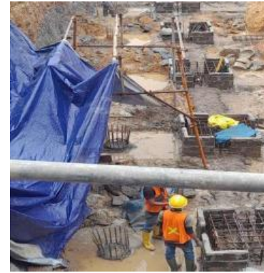
Gambar 6. Pekerjaan Pile Cap dan Tie Beam
