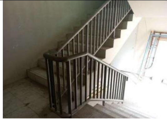
Gambar 27. Pek. Railing Tangga Darurat
