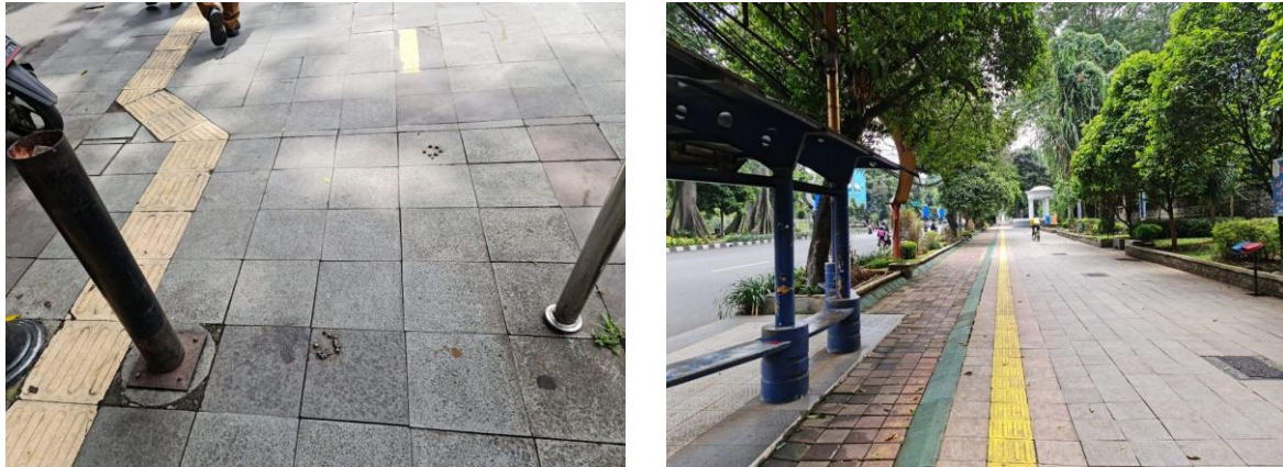
Gambar 1. Kondisi eksisting sebelum dilakukan pembangunan jalur sepeda
