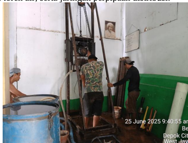
Gambar 2 Proses penggalian sumur bor baru
