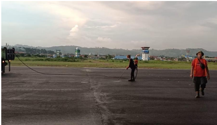
Gambar 2. Kondisi Eksisting Runway 27 UPBU Kelas I Domine Eduard Osok – Sorong
