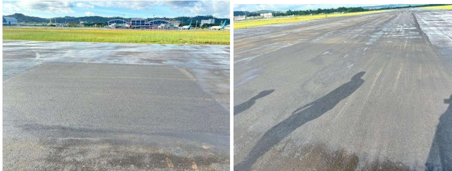
Gambar 8. Kondisi Runway setelah pekerjaan
